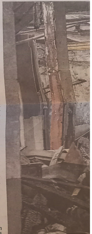
Dans le local de stockage municipal, la chaleur a déformé la charpente métallique. Photo ER/H. COUILLARD
