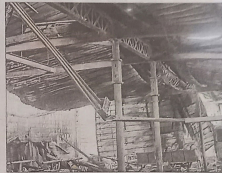
Dans le local de stockage municipal, la chaleur a déformé la charpente métallique. Photo ER/H. COUILLARD
